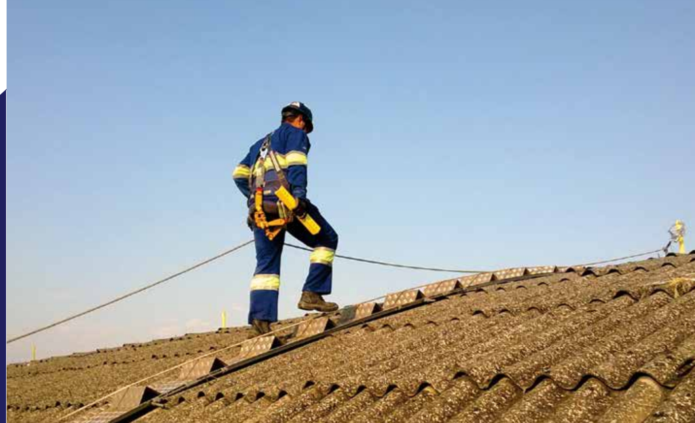
Linha de vida em telhado
